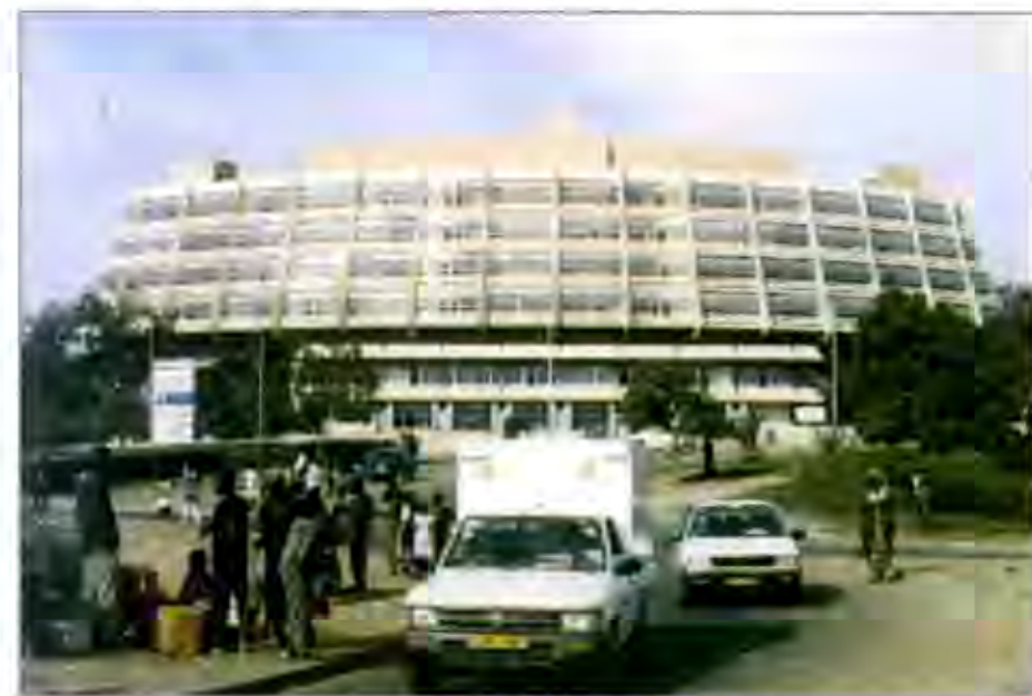
Immeuble de l'Office National des Ressources Minières (source : Ibro Alkassoum, 2002)
