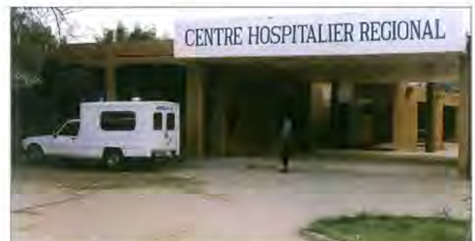
Façade hôpital régional de Niamey (source : Mamoudou Djibo, 2002)
