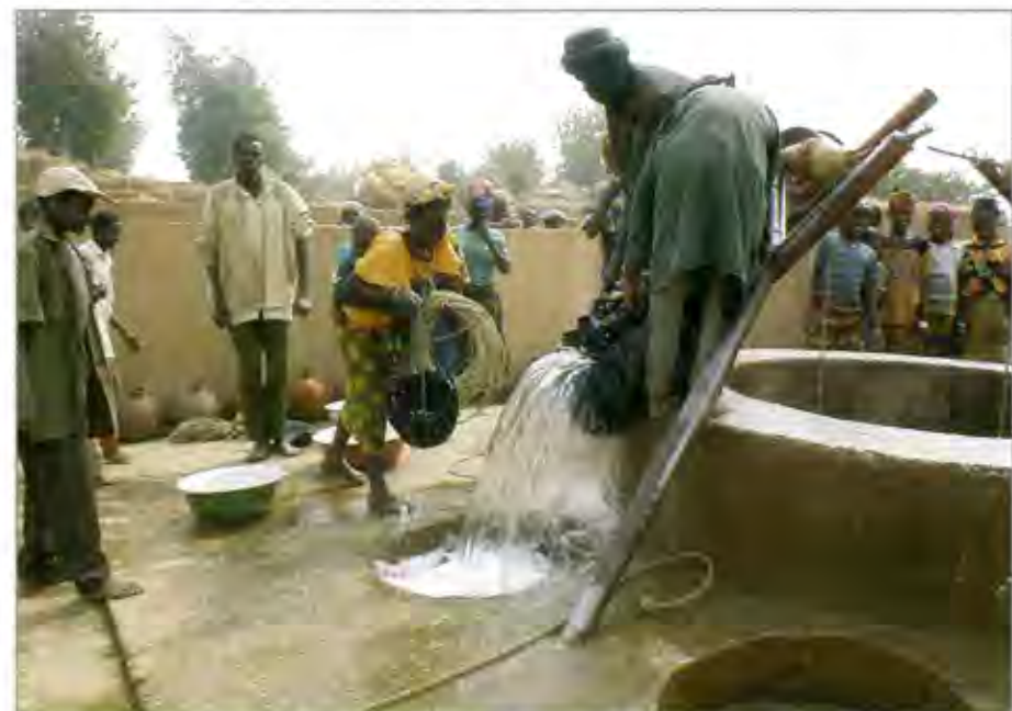
Aménagement d'un puits dans la région de Maradi (source : BA-PHNS 2001)
